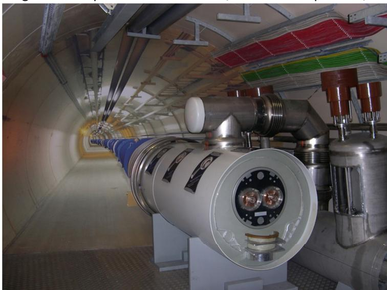
Figura 3: Il tunnel del CERN, con l'LHC in costruzione (2005).
